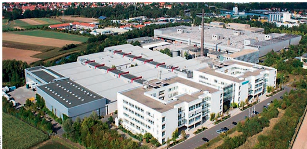
Siemens Motion Control in Erlangen: Sukzessive wurde in den letzten Jahren der Produktionsbereich vom klassischen Linientakt zu einer flexiblen, produktiven Lean-Fertigung umstrukturiert. Mit den Lötanlagen von Seho soll die angestrebte Matrix-Fertigungskonzept gelingen.
